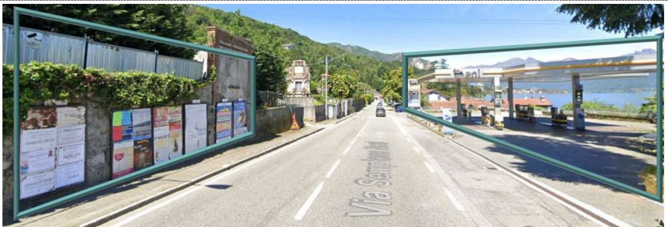
Tratto della SS 33 con situazioni di degrado percettivo.
