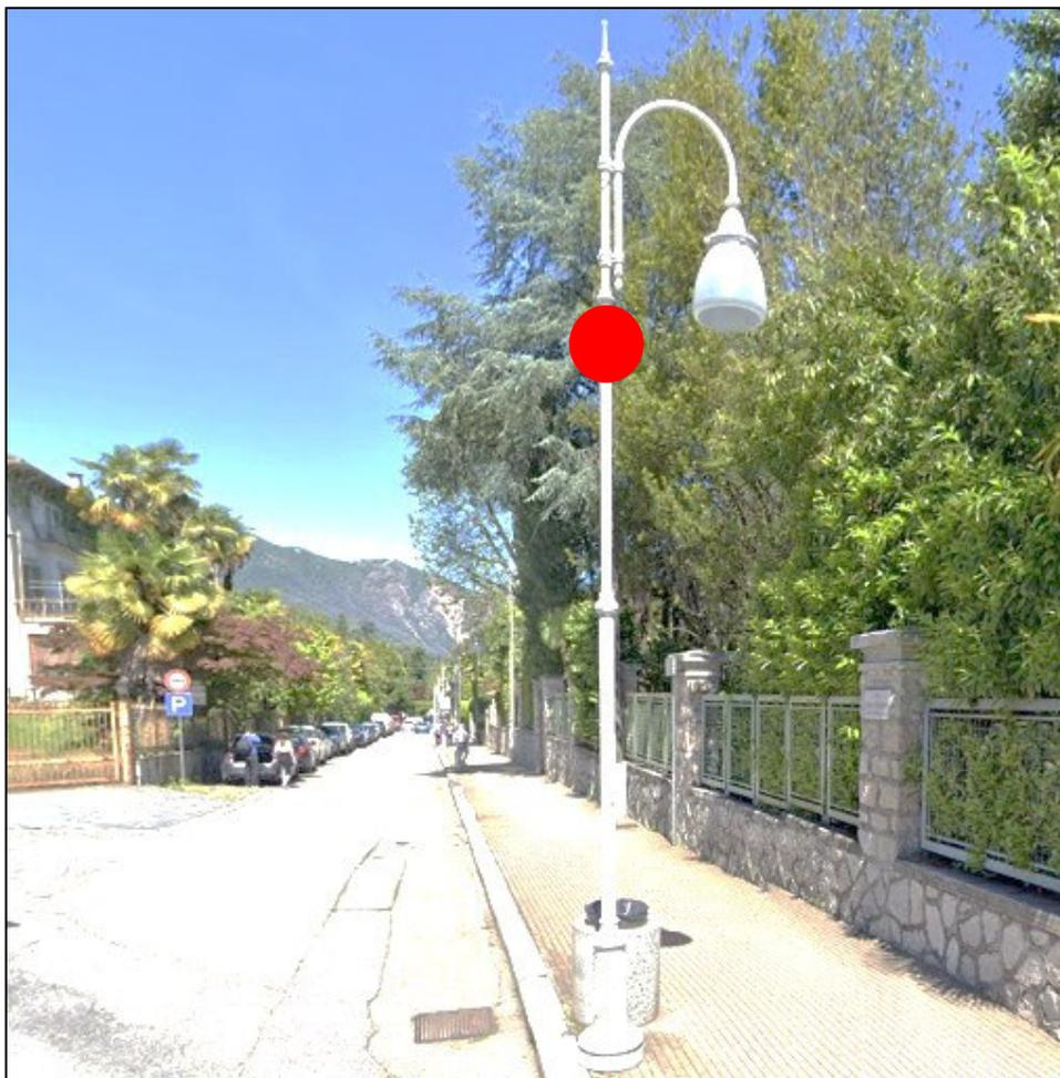
**19 - PASSEGGIATA PARCO GIOCHI LUNGOLAGO** – 1 TELECAMERA IN PROGETTO – la postazione controlla il parco giochi esistente a fianco della Verbanella. Il segnale è trasmesso a QE5 con F.O., e da questo rilanciato su tracciato QE5 – QE3, con trasmissione delle immagini via ponte radio QE3 – Municipio – Vigili Urbani.
