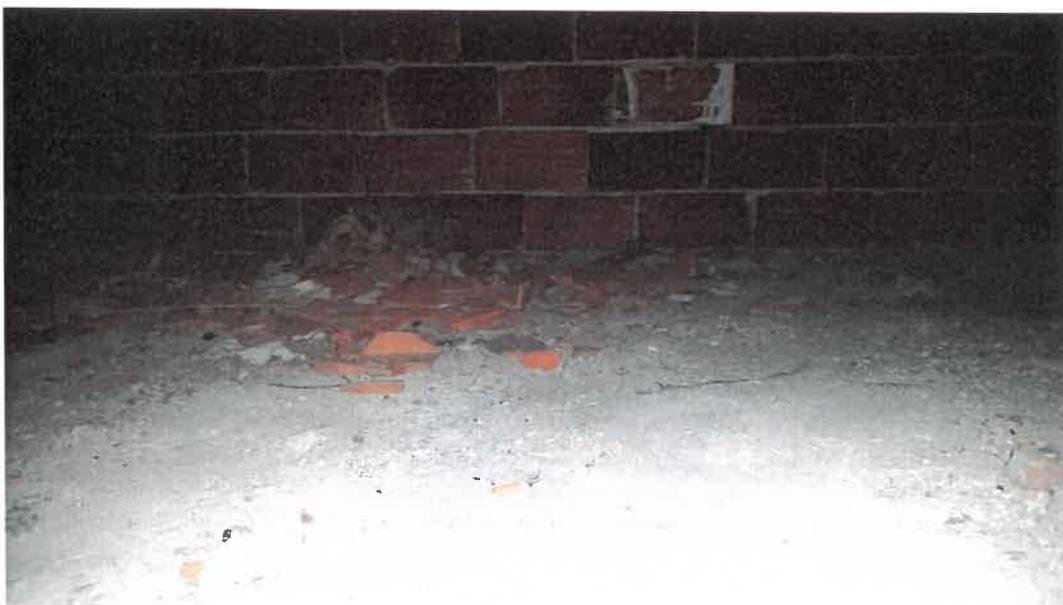
Sottotetto: presenza di detriti edili probabilmente contaminati
