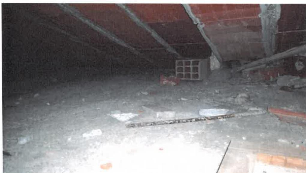
Sottotetto: solai e falde in latero cemento tipo SAP.
