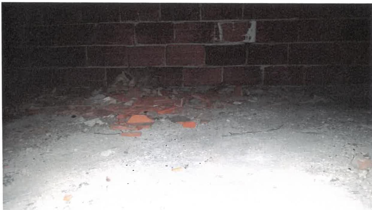
Sottotetto: presenza di detriti edili probabilmente contaminati
