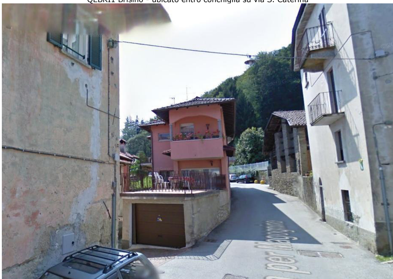
QEBRI2 Brisino - ubicato su muro di facciata in via per Magognino
