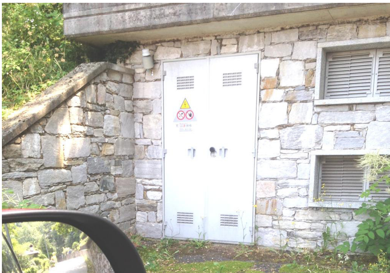
QE0019 Brisino - ubicato entro cabina ENEL sulla via per Locco
