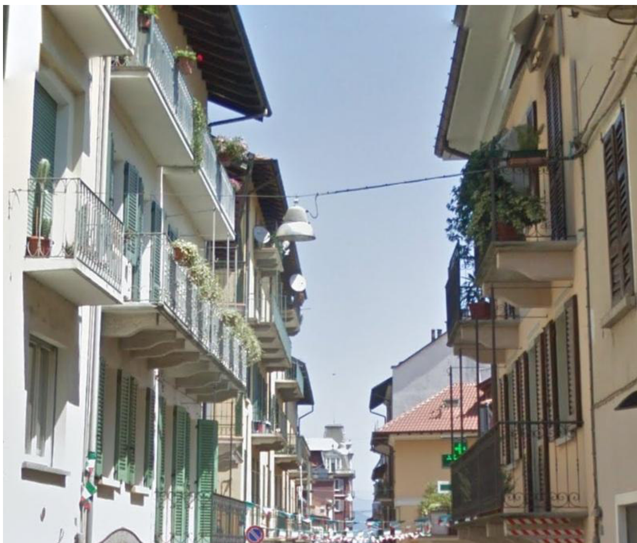
TESATA MURO - MURO CON ARMATURA SOSPESA - CENTRO STORICO
