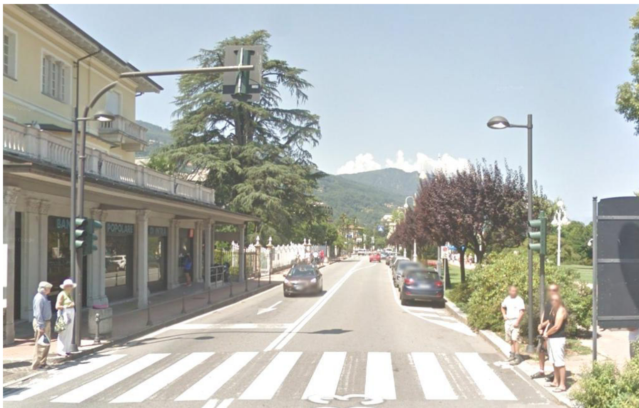
PALI IN ACCIAIO PER PASSAGGI PEDONALI CORSO UMBERTO I°
