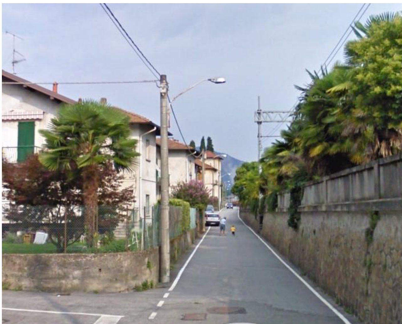
PALO IN CEMENTO CON SBRACCIO IN ACCIAIO VIA BAVENO - TIPICO CON PROMISCUITA' MECCANICA ED ELETTRICA
