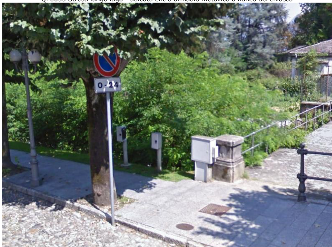
QE0054 Stresa Lido - ubicato entro conchiglia a marciapiede a metà di viale Lido
