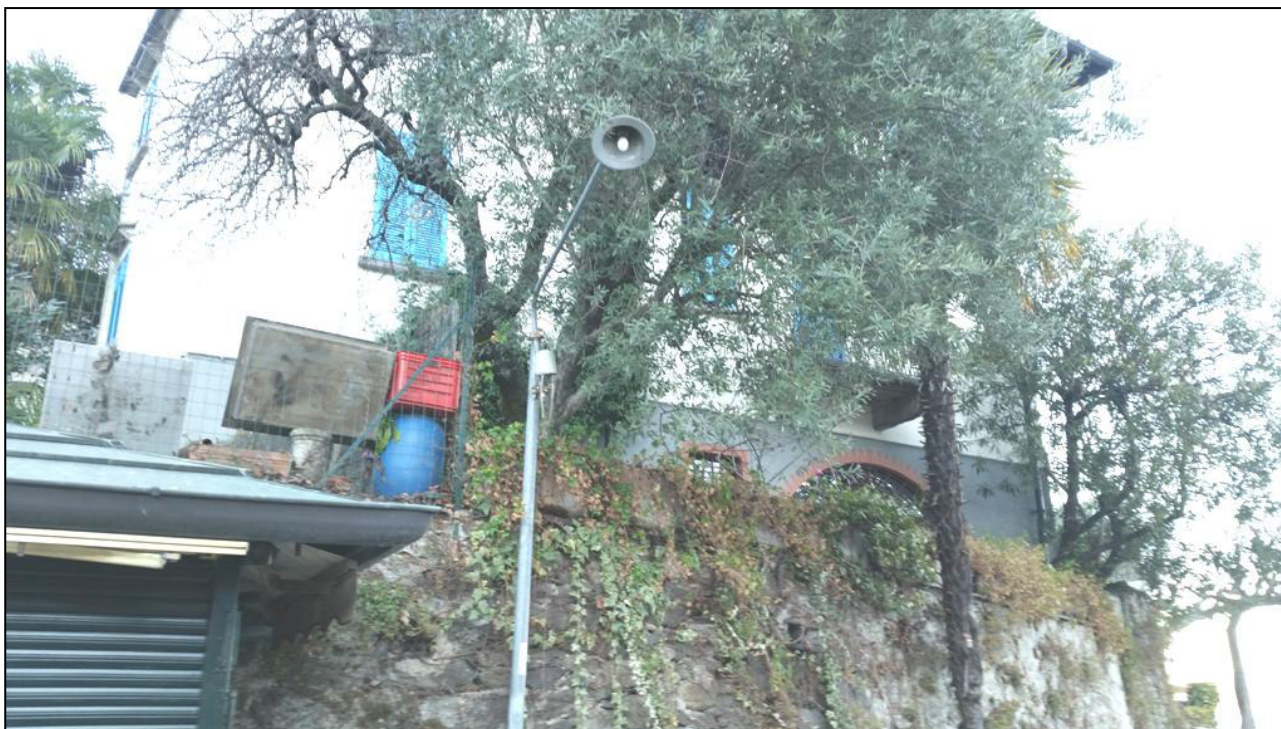
PALI IN ACCIAIO CON ARMATURE APERTE SULL'ISOLA PESCATORI
