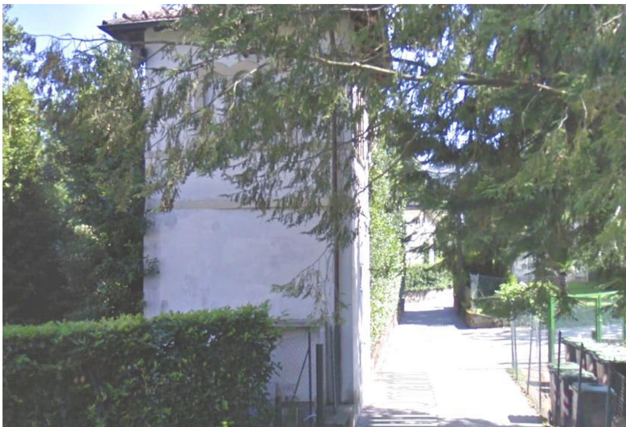
QE0006 Stresa centro - ubicato entro cabina ENEL di via Omarini presso hotel Borromeo - accesso da via Omarini
