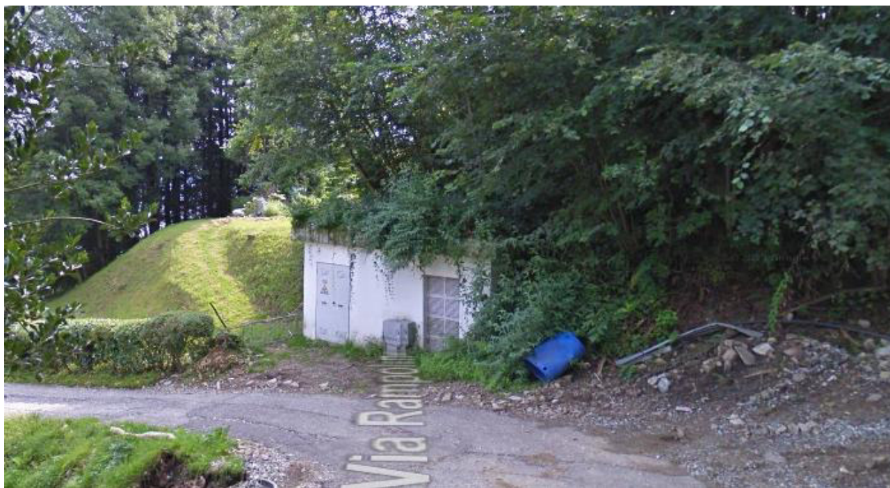
QE0031 Campino - ubicato entro cabina ENEL all'inizio della via Rampolino
