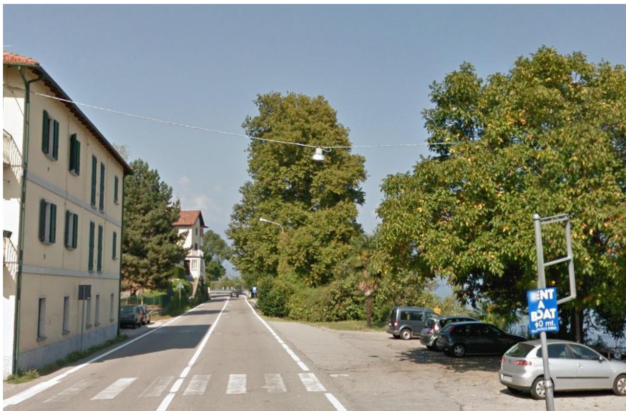
TESATA PALO - MURO CON ARMATURA SOSPESA - SS 33 LOC. SAN GIOVANNI
