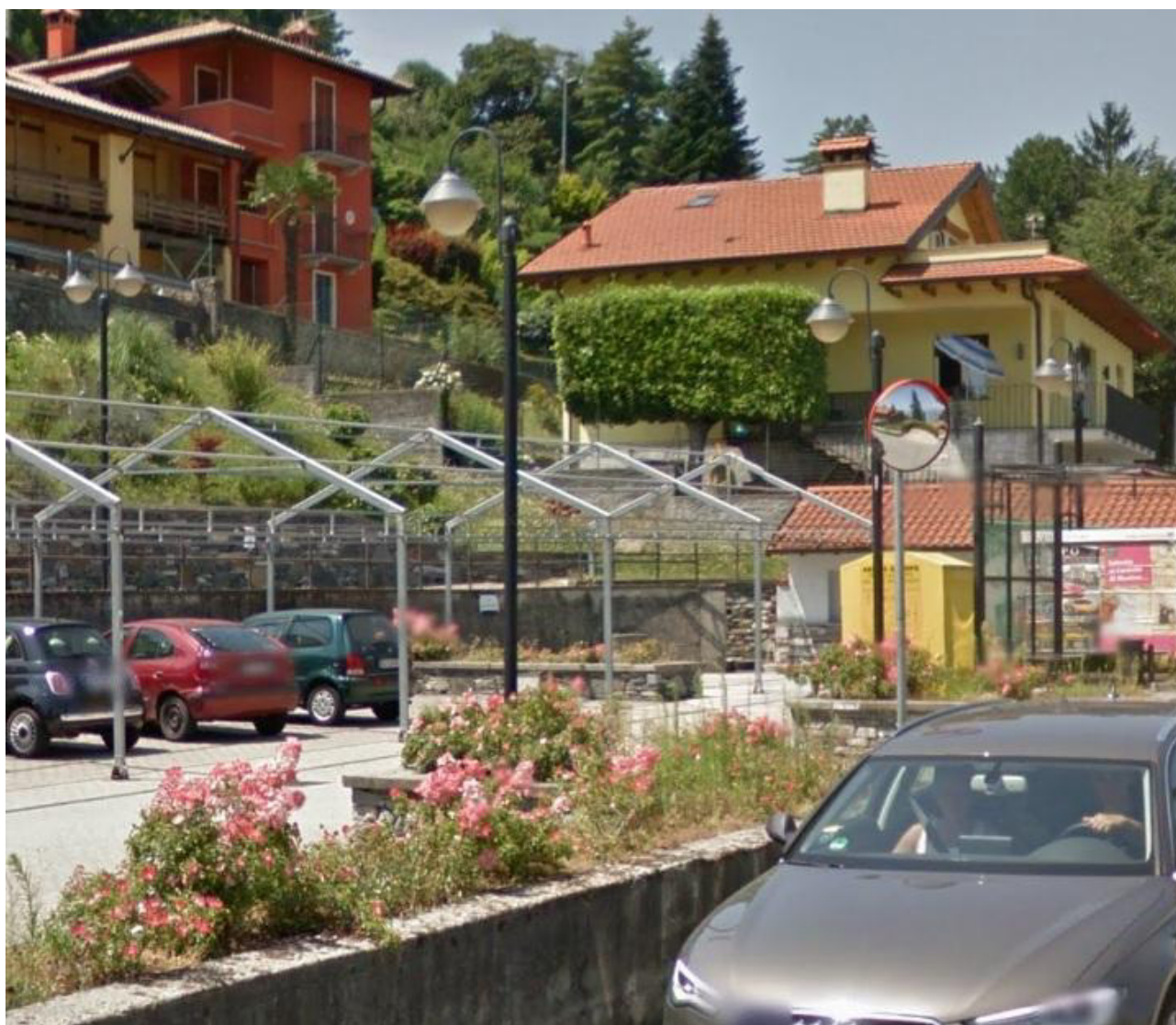
PALO ORNAMENTALE IN ACCIAIO A 1 O 2 SBRACCI PARCHEGGIO DI VEDASCO
