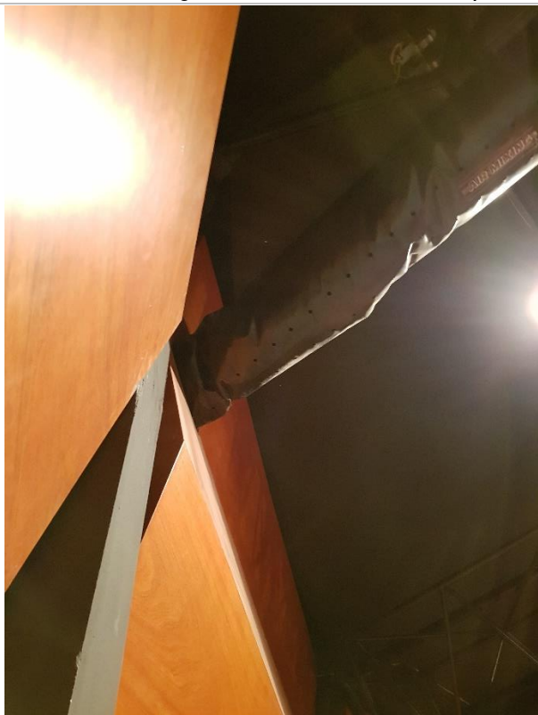
Particolare uscita canale in PVC forato
