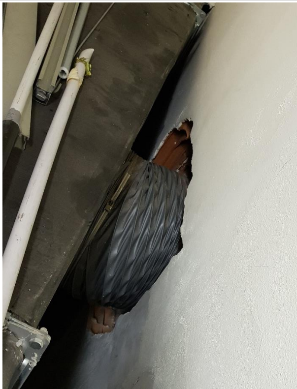
Particolare collegamento flessibile in PVC spiraleto
