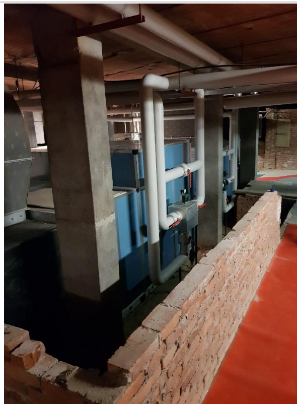
Visuale UTA in interrato sottoplatea
